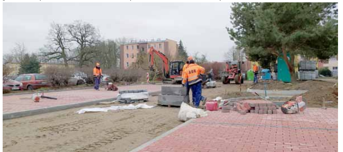
Miejsca postojowe za blokami już właściwie gotowe
