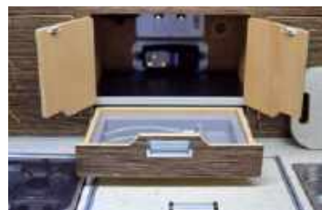
Szuflada na sztucce, nad nią szafka, w której ukryto centralkę sterowania zasilaniem z paneli fotowoltaicznych. System jest automatyczny i bezobsługowy
