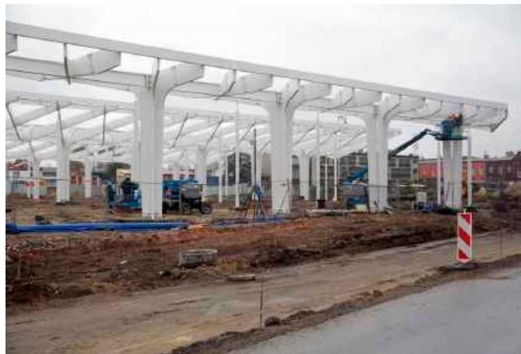
Największą inwestycją w przyszłym roku będzie dokończenie budowy Dworca Metropolitalnego i przebudowy układu komunikacyjnego wokół niego. Prace kosztować będą ponad 178 mln zł, z czego ponad 77 mln zł pokryje unijna dotacja
