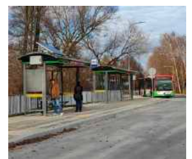
Nowe pętla autobusowa na ul. Osmolickiej
