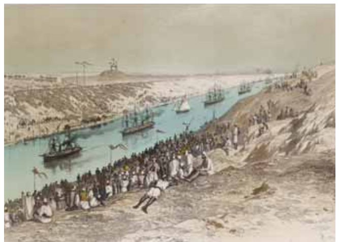
Budowa Kanału Sueskiego.
