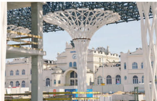
Stan zaawansowania prac na całej budowie przekracza już grubo 40 proc. a ich wartość to ponad 130 mln zł.
