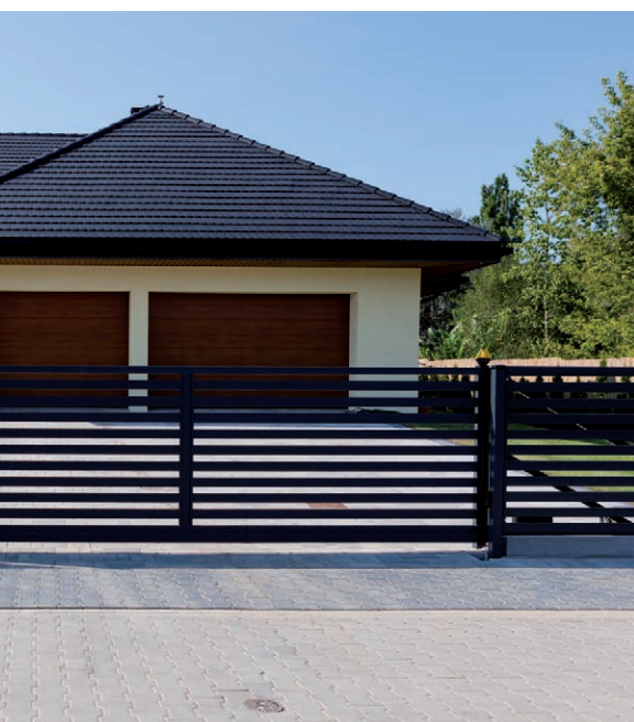
Ogrodzenie frontowe w kolorze antracytowym. Wykonane z profili zamkniętych o wymiarach 8 x 2 cm. Ogrodzenie zostało osadzone na podmurówce systemowej o wysokości 25 cm, a jego uzupełnienie stanowią brama przesuwna z automatyką oraz furtka z elektrozaczepem.
