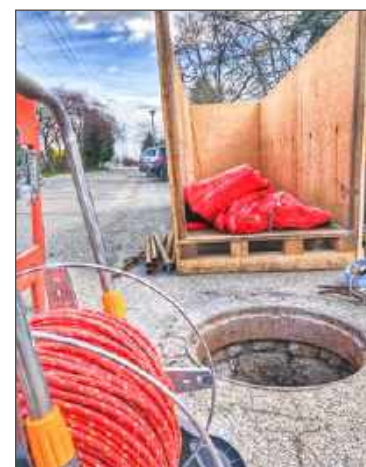
Prace przy ul. Brzegowej. fot. Wodociągi Dębickie
