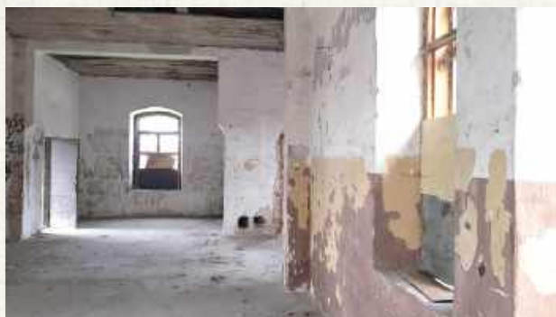
Wnętrze nie zachowało żadnych śladów dawnego liturgicznego wystroju. Można przyjąć, że najodleglejsza część stanowiła część ołtarzową. Nie znamy żadnego zdjęcia wyposażonej świątyni
