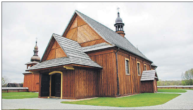
W kościele Świętej Trójcy w Pratulinie zostanie wymienione poszycie dachowe
