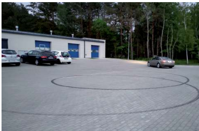
Tzw. „palenie gumy” ktoś „uprawiał” na parkingu przed budynkiem magazynowym, gdzie będzie wypożyczalnia sprzętu wodnego
