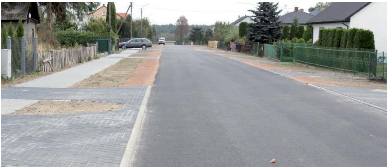
Jedną z najnowszych dróg na terenie Gminy Kąkolewnica jest ta wykonana w Brzozowicy Dużej
