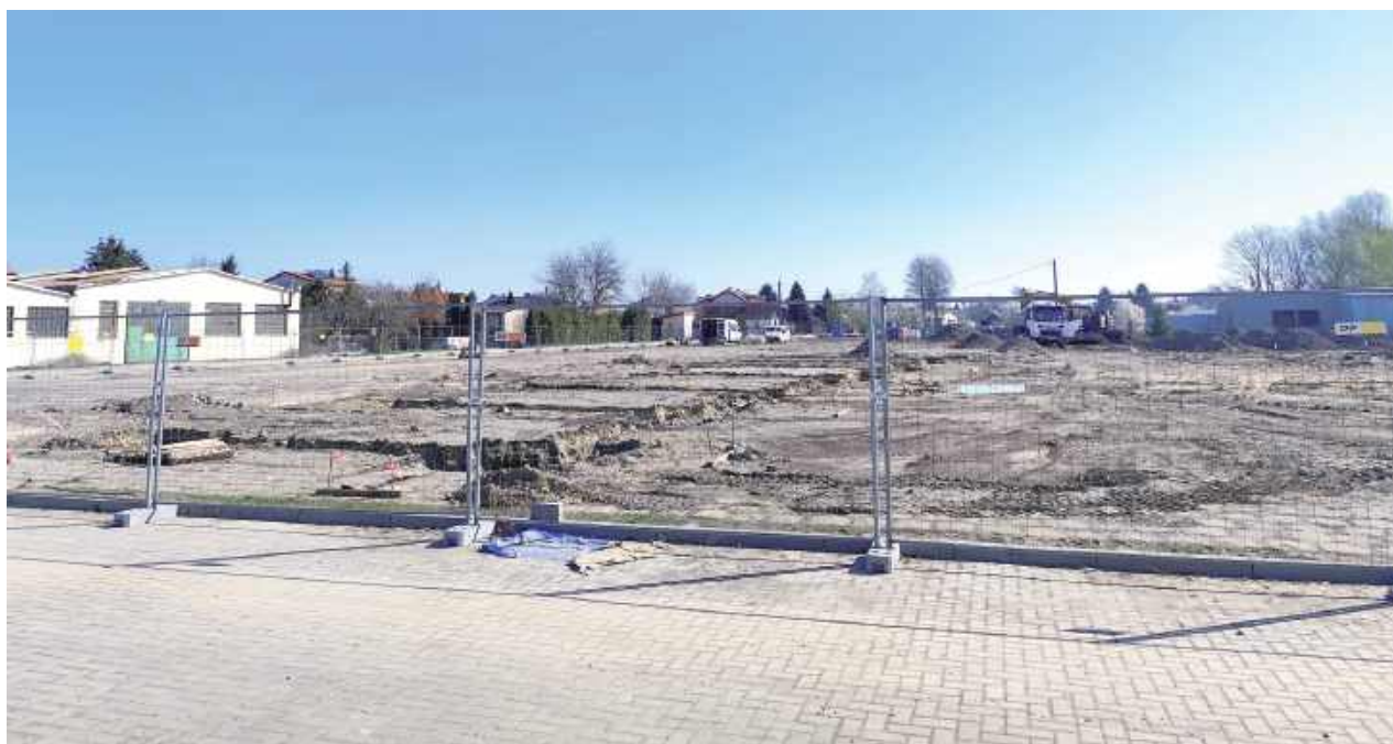
Plac zostanie utwardzony, powstaną również dwie wiaty
