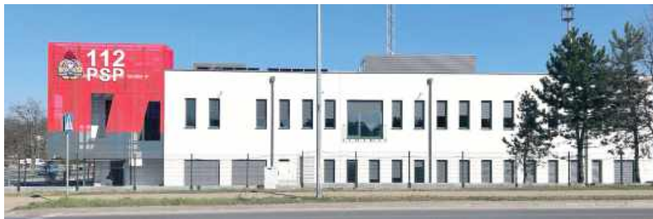
Strażacy do połowy maja powinni już przenieść się do nowej siedziby przy skrzyżowaniu ul. Słowackiego i Lubelskiej
