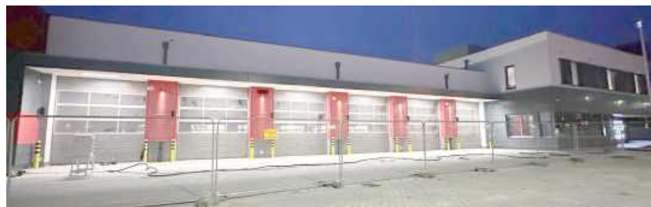
W nowej komendzie będzie więcej miejsca na samochody bojowe i sprzęt
