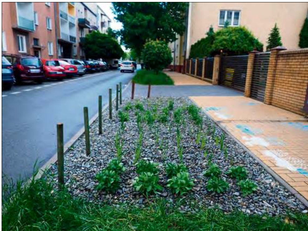
Ogród deszczowy jest nieco obniżonym w stosunku do otoczenia terenem zielonym, który spełnia funkcję budowli hydrotechnicznej.
