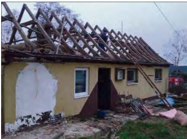
8 grudnia 2014 roku rozpoczęła się budowa nowej remizy Ochotniczej Straży Pożarnej.
