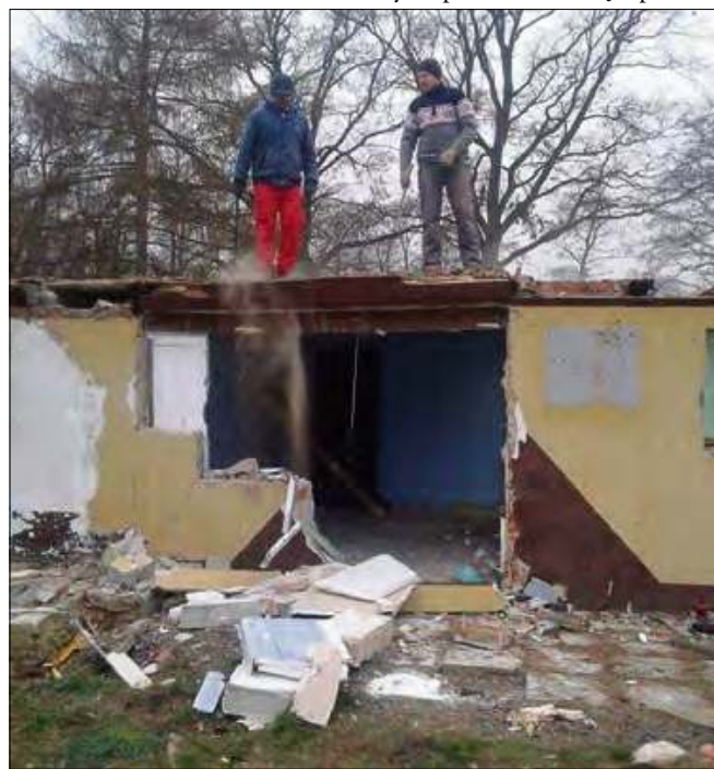
Budowa nowej remizy w Pietnej.
