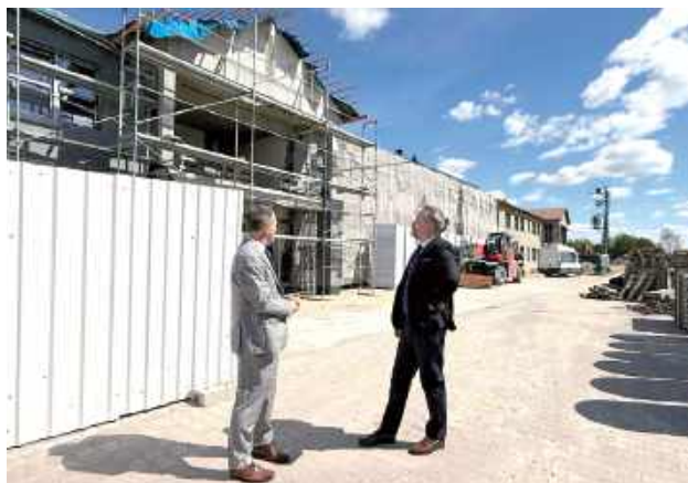
Latem rozbudowa była jeszcze na wczesnym etapie, teraz zmierza ku końcowi - zapewnia wójt Piotr Dragan (z lewej). Kilka tygodni plac budowy odwiedził wicewojewoda lubelski Wojciech Wołoch
