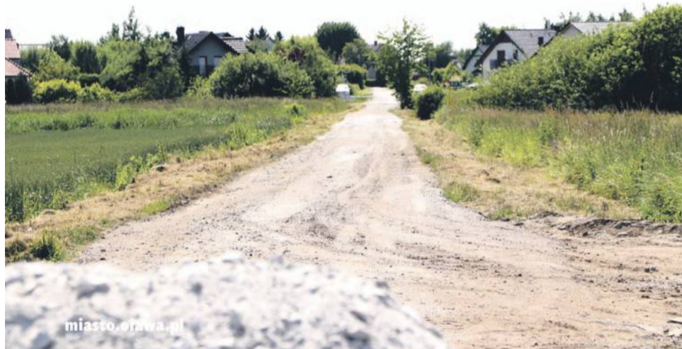
Na tym odcinku będzie asfalt - ulica Brylantowa
