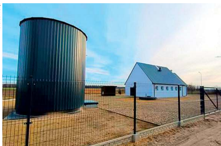
Zakończyła się rozbudowa hydroforni w Szczepkowie
