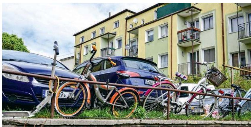
Budynek, w którym znajduje się mieszkanie Jerzego Ż. zakupione przez Karola Nawrockiego. Gdańsk Siedlce, 2025 r.
