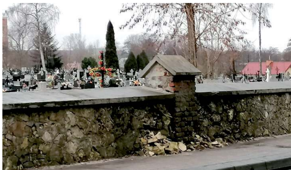
Dotacja udzielona przez Radę Gminy w Chodlu przeznaczona jest na odbudowę zniszczonego parkanu cmentarnego przy ulicy Strażackiej
