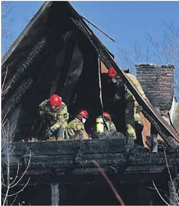
Dogaszanie i rozbiórka spalonego po raz kolejny zabytku.
