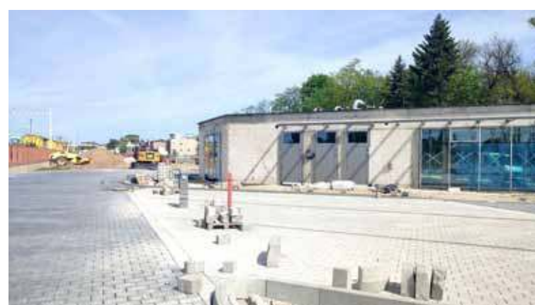
Trwają również prace przy wykańczaniu budynku socjalno-usługowego
