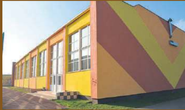
Tak prezentuje się nowa elewacja obiektu.
