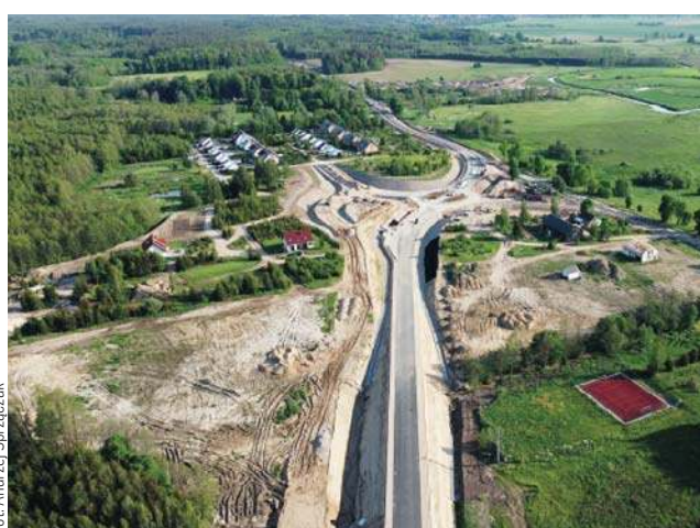
Obwodnica Smolajna w ciągu DK51
