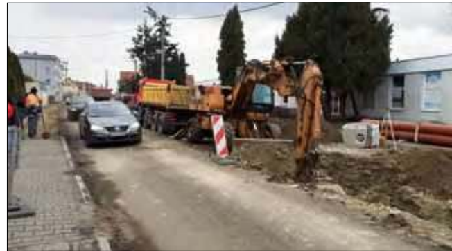
Mniejsze auta przeciskają się przez plac budowy, gorzej z ciężarówkami...
