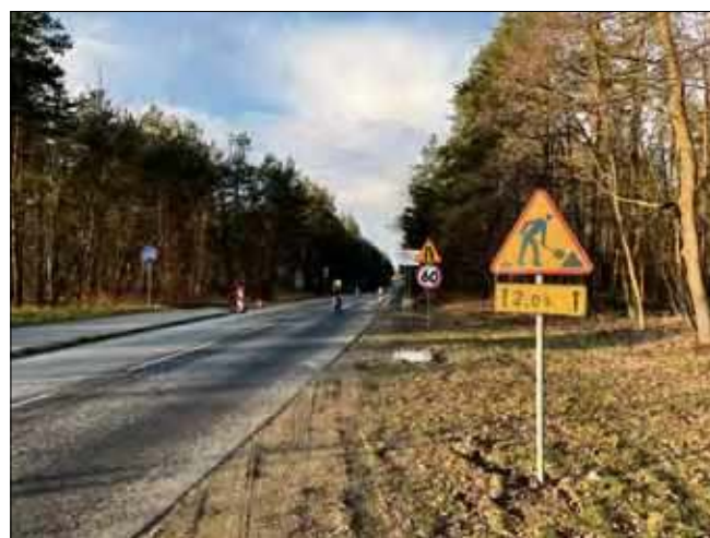
Nowa nawierzchnia jezdni wraz ze wzmocnieniem podbudowy zostanie położona na długości 1882 m.
