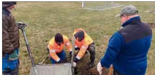
Pracownicy ZRS-u wykorzystali dobre warunki atmosferyczne aby zamontować urządzenie.
