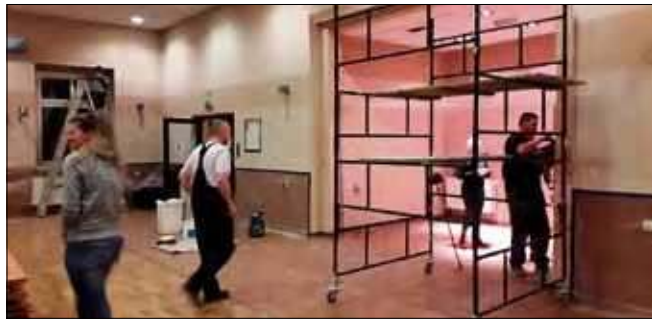
Prace przebiegały szybko i sprawnie.
