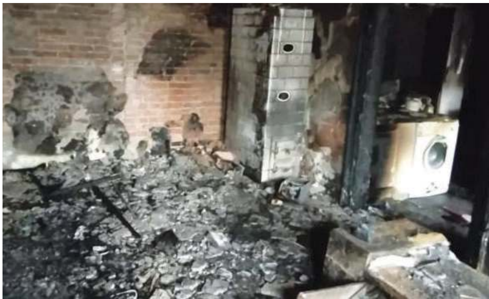
Przerażające zdjęcie z wnętrza budynku, udostępnione na stronie Urzędu Miejskiego
