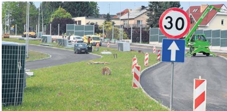
Termin zakończenia budowy pierwszego odcinka to 30 września
