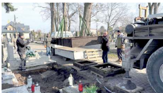
Prace remontowe trwają, ale do ich pełnej realizacji brakuje jeszcze 5 tys. zł
