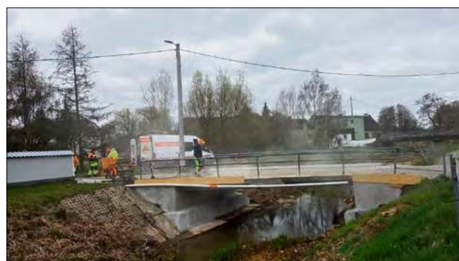
Prace idą pełną parą.
