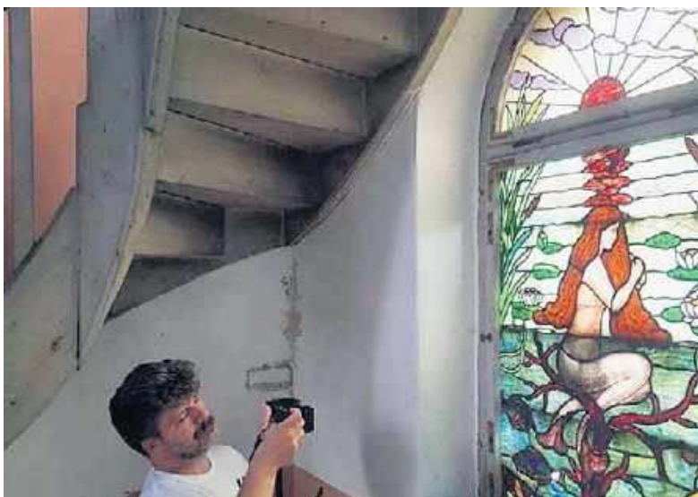
Unikatowy witraż z syreną był w opłakanym stanie. Dzięki interwencji zapadła decyzja o jej renowacji. Znowu będzie cieszyć oczy
