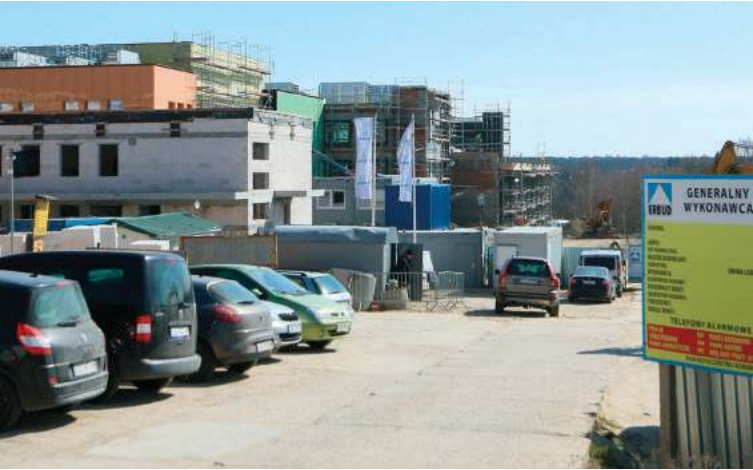
Budowa szkoły dobiega końca
