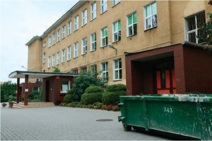
SP nr 6 przy ul. Czwartaków 11 już szykuje się do remontu
