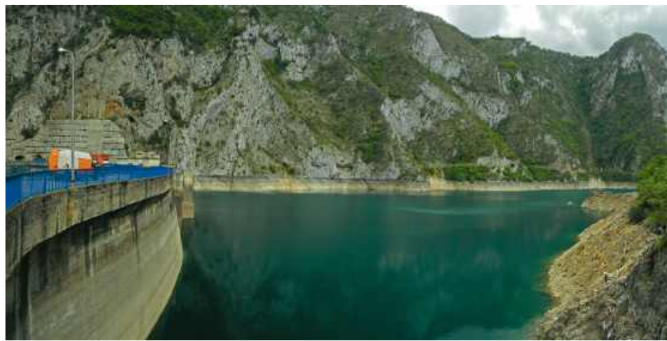
Mratinje to druga co do wysokości tama w Europie. Spad zasila hydroelektrownie o mocy 342 MW.
