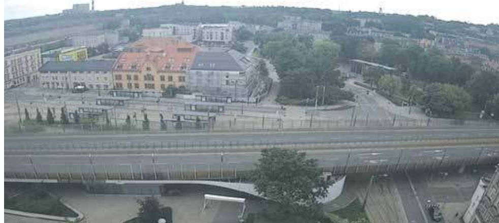
Opustoszała estakada w Chorzowie
