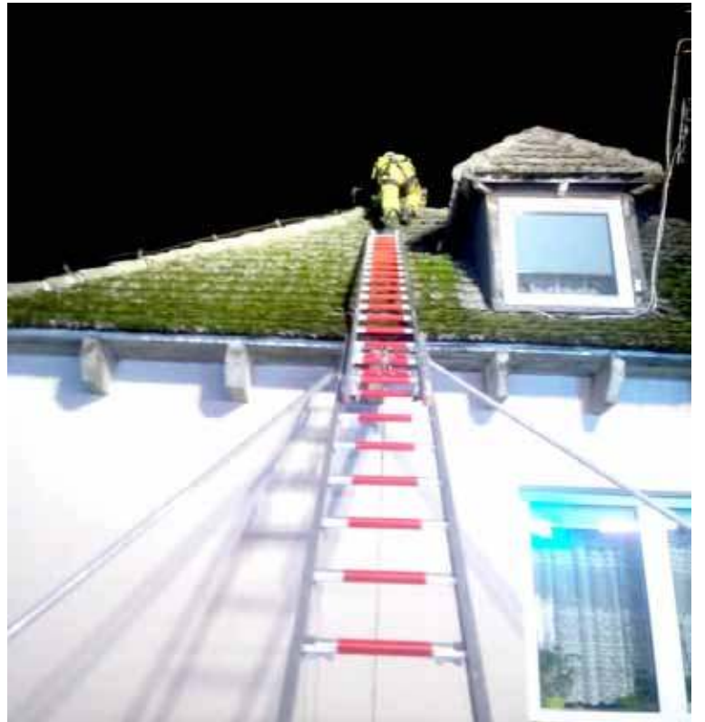
W minioną niedzielę strażacy z Dolice gasili pożar sadzy w przewodzie kominowym w miejscowości Moskorzyn. Foto. OSP. Dolice.
