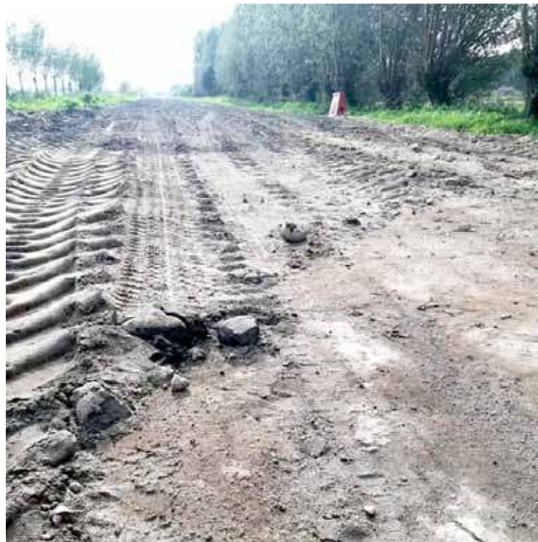
Jak zapowiada burmistrz Suchania, do czasu przeprowadzenia remontu droga ma być systematycznie utwardzana.
