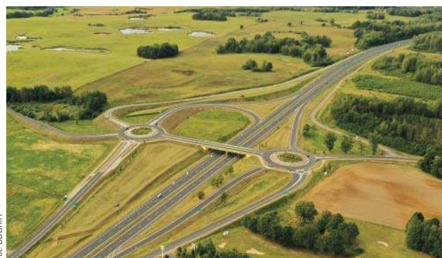
Budowa drogi S16 Mrągowo — Orzysz — Ełk
