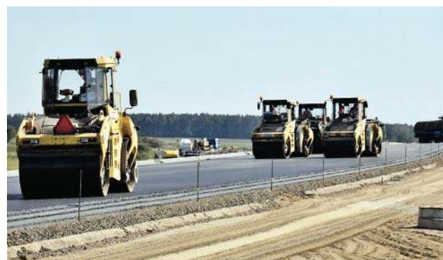
Budowa drogi S5 Ostróda — Nowe Marzy
