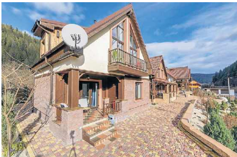
Legalizacja samowoli budowlanej jest obecnie łatwiejsza, ale trzeba spełnić kilka warunków.
