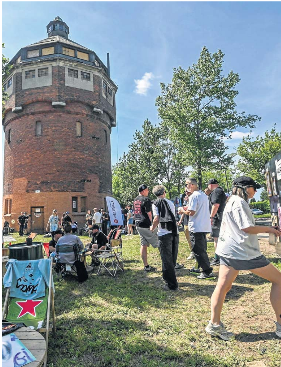
Piknik zorganizowany pod Wieżą Ciśnień promował projekt renowacji tego obiektu
