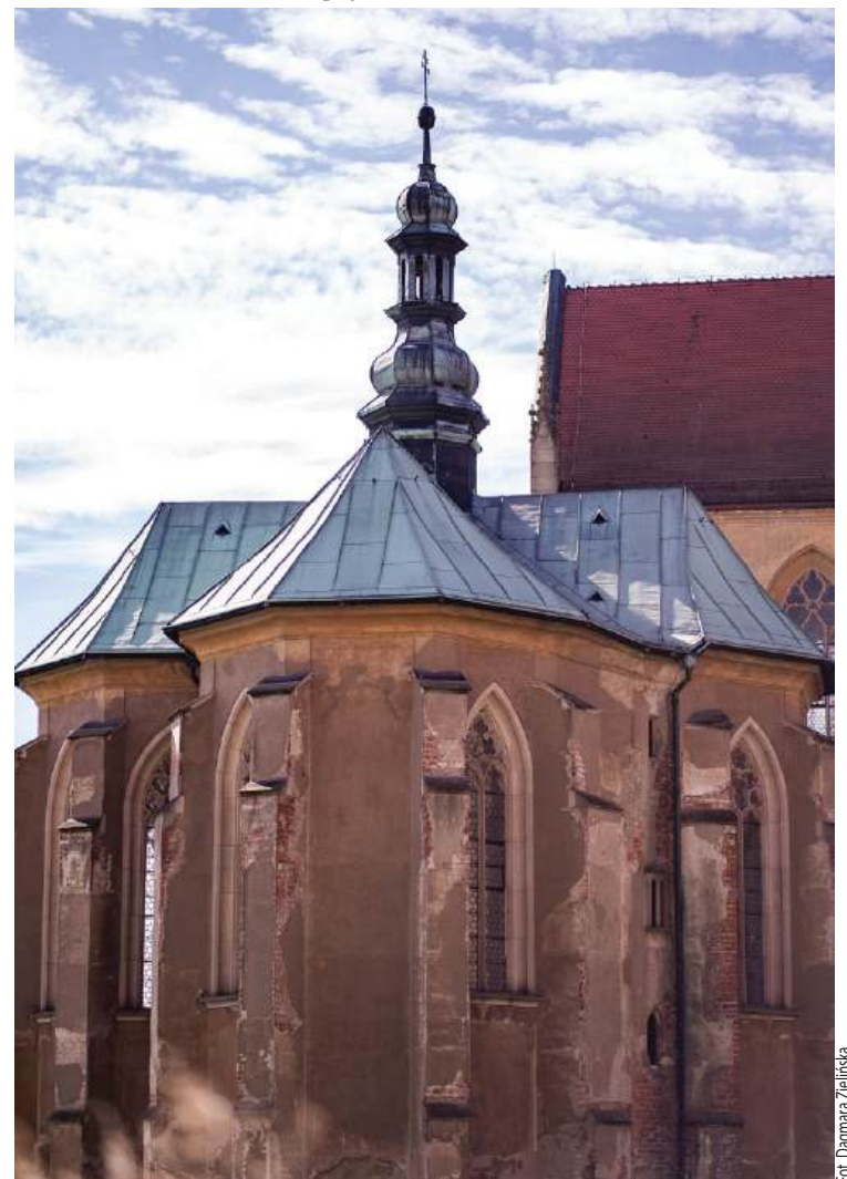
Kaplica książęca przy kościele klasztornym z zewnątrz.
