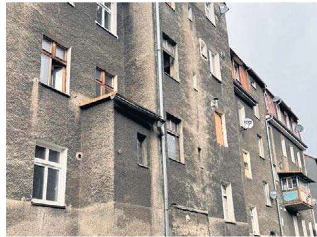
Niebawem ruszy remont starej kamienicy przy ul. Armii Krajowej, umowę już podpisano
