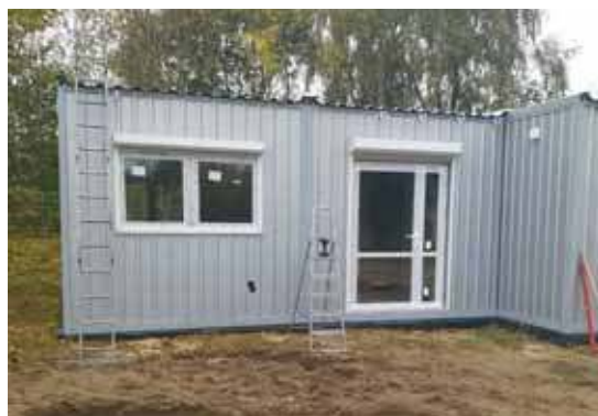
Niedawno zakończono budowę świetlicy kontenerowej w PawłóWKu
