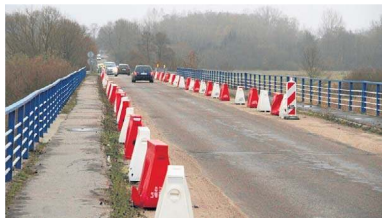
Most stalowy dziewięcioprzęsłowy z płytą żelbetową został wybudowany w 1978 roku
