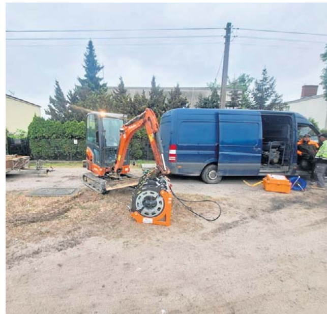
Na Olsztyńskiej pojawiła się ekipa, która zajmie się usuwaniem kolizji w infrastrukturze gazowej
