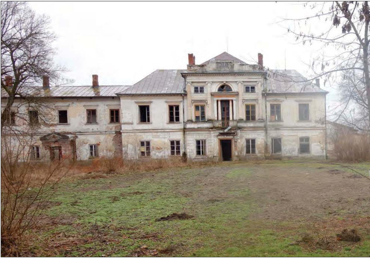
■ Pałac w Sobieszynie niszczeje w zastraszającym tempie. - Serce boli, gdy patrzę na ten obiekt. Okna są powybijane, drzwi i podłogi wyłamane, piec i komin zrujnowany. Jak tak dalej pójdzie, to budynek zostanie zrównany z ziemią. Mimo obowiązku zabezpieczenia obiektu, prezydent Warszawy nic z tym nie robi - mówi wójt Barbara Pawlak
