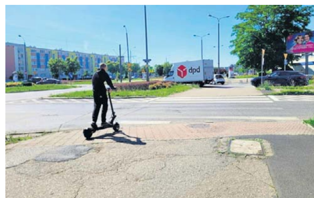
Brakujący fragment drogi rowerowej przy Wojska Polskiego zostanie uzupełniony. Ogłoszono przetarg
