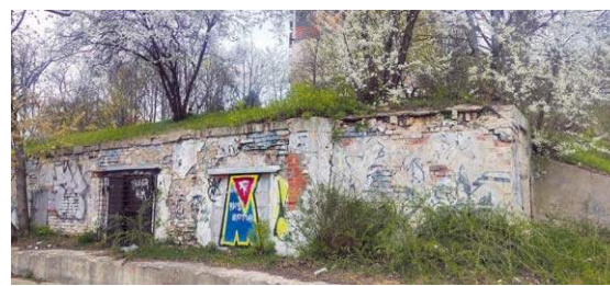
Pozostałości starej lodowni przy ulicy Północnej
