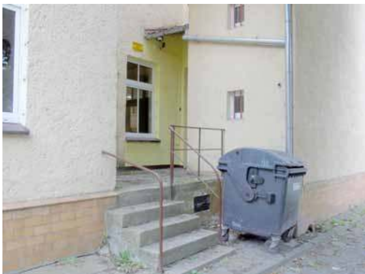
Budowa podjazdu przy drugim wejściu do budynku to nie takie proste zadanie
