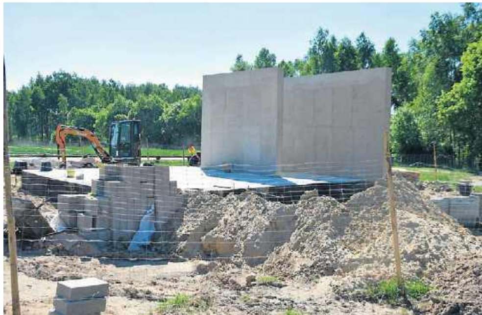
Na Krakowej Górze, tuż pod Borkowicami, powstaje leśny amfiteatr. Inwestycja ma na celu zagospodarowanie atrakcyjnego terenu w otoczeniu przyrody.
