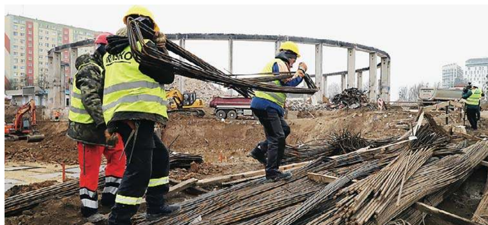
LISTOPAD. Wizyta na budowie nowej Uranii
