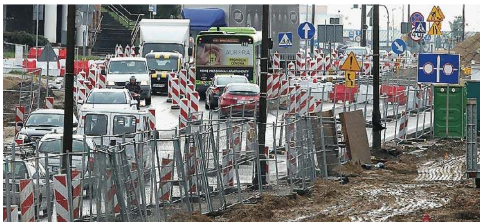
LISTOPAD. Tymczasowe przejścia dla pieszych na ul. Wyszyńskiego
