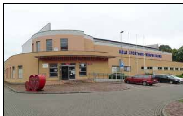
Już wkrótce dzięki wsparciu Urzędu Marszałkowskiego wysłużone siedziska w łobeskiej hali sportowo-widowiskowej zostaną wymienione na nowe.
