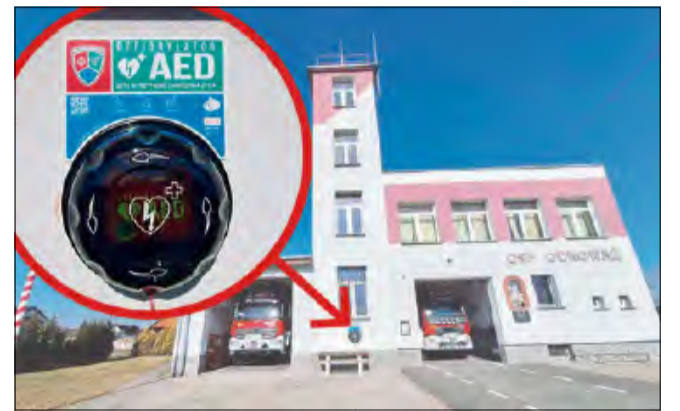
AED już w Odrowążu – urządzenie zamontowano na remizie OSP i jest ogólnodostępne.
