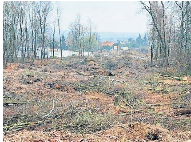
Trwają prace związane z wytyczeniem śladu przyszłej trasy oraz wycinka drzew na dalszym przebiegu
